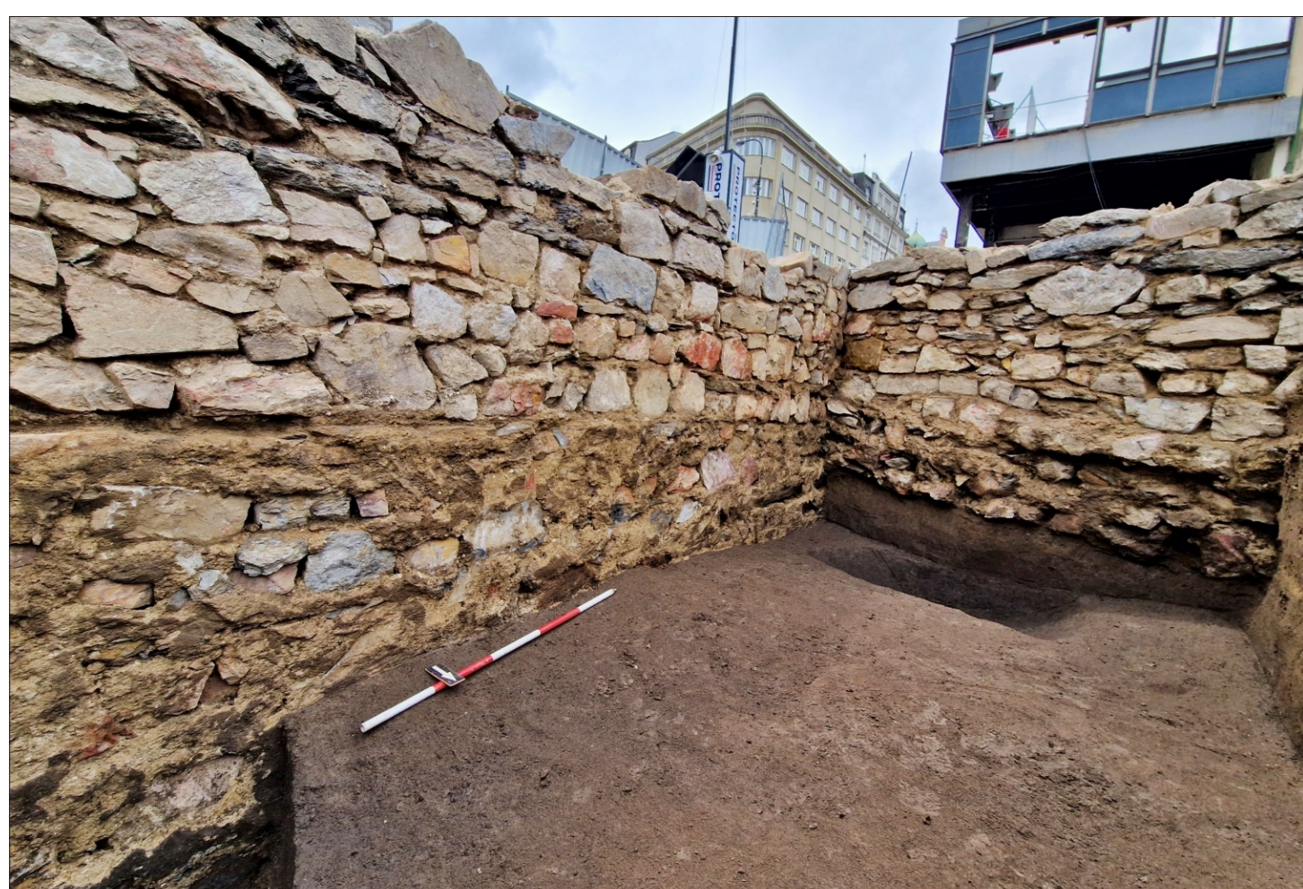
Základy severní věže gotické Horské (Šibeniční) brány (vlevo) a hradební zdi. Touto branou procházeli ve středověku také odsouzení na nedaleké popraviště za hradbami města.
